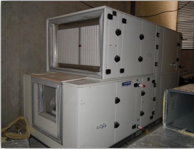
Le traitement d'air des vestiaires et locaux annexes est réalisé par une centrale double flux de 7000 m<sup>3</sup>/h comprenant :
