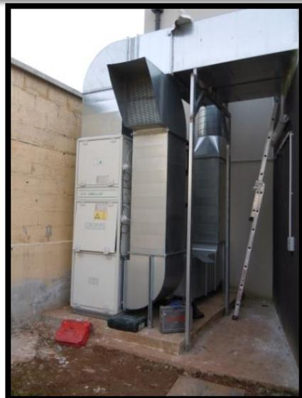
Le chauffage, le rafraîchissement et le traitement d'air de la salle « espace scène » sont réalisés par une centrale de traitement d'air, installée en extérieure.
